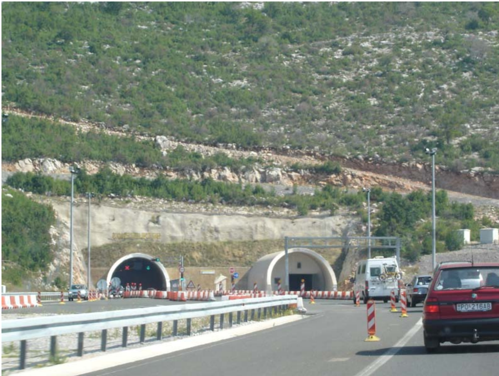
Sveti Rok Tunnel Entrance
