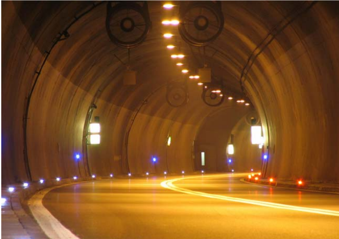
Sveti Rok Tunnel
